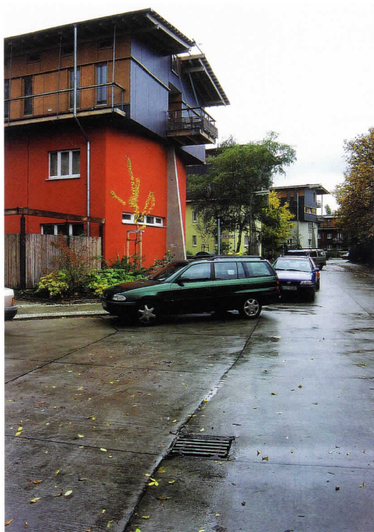
Bild 2. Lüdeckestraße mit Kopfbauten und Aufstockung der 1998 modernisierten Wohnhäuser. Dach- und Straßenflächen sind Einzugsgebiete des genutzten Regenwassers. Dies entspricht nicht den heutigen Regeln der Technik, ist jedoch als Sonderbauweise mit spezieller Aufbereitung bis heute in Betrieb. (Foto: Klaus W. König)
