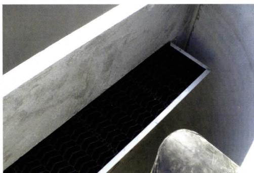
Bild 3: Lamellenklärer ViaTub aus Betonfertigteilen und speziellen Einbauten, die Sedimentation und Flotation ermöglichen. Mit Sammelraum für schwimmende Partikel (Fotos 3–6: Mall)
