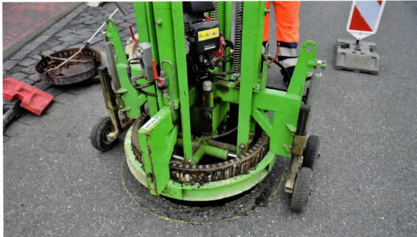
Bild 1: Ziehen der schadhaften Schachtabdeckung
