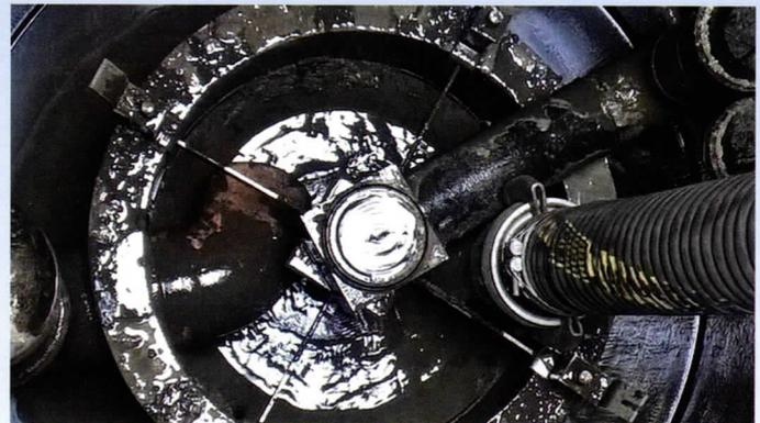
Bild 6: Substratfilter ViaPlus nach „erfolgreichem Einsatz“, allerdings ohne Wartung
