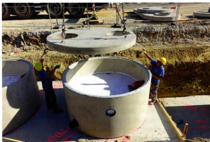
Bild 4: Gewässerschutzfilter ViaGard. Versetzen des Filterschachtes aus Betonfertigteilen mit Funktionselementen, die das zu reinigende Wasser von oben nach unten durchfließt
