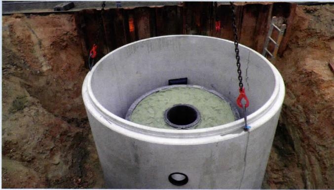
Bild 5: Substratfilter ViaPlus 3000. Einbau des Filterschachtes aus Betonfertigteilen mit Funktionselementen, die das zu reinigende Wasser horizontal durchfließt
