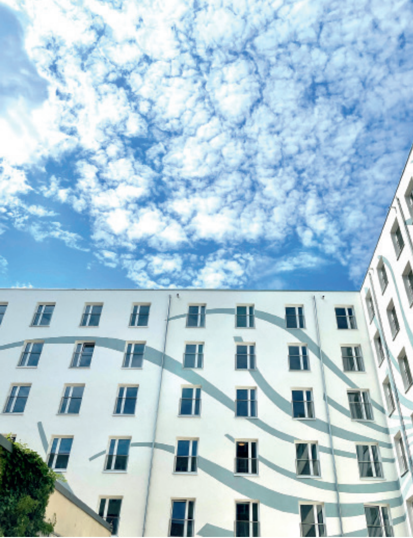
Die Berlinovo baute 2021 eine siebengeschossige Apartmentanlage für 442 Studenten in Modulbauweise. Das gesamte Duschwasser wird nach Aufbereitung zur WC-Spülung verwendet. Zugleich wird Wärme zurückgewonnen und für die Trinkwassererwärmung eingesetzt
