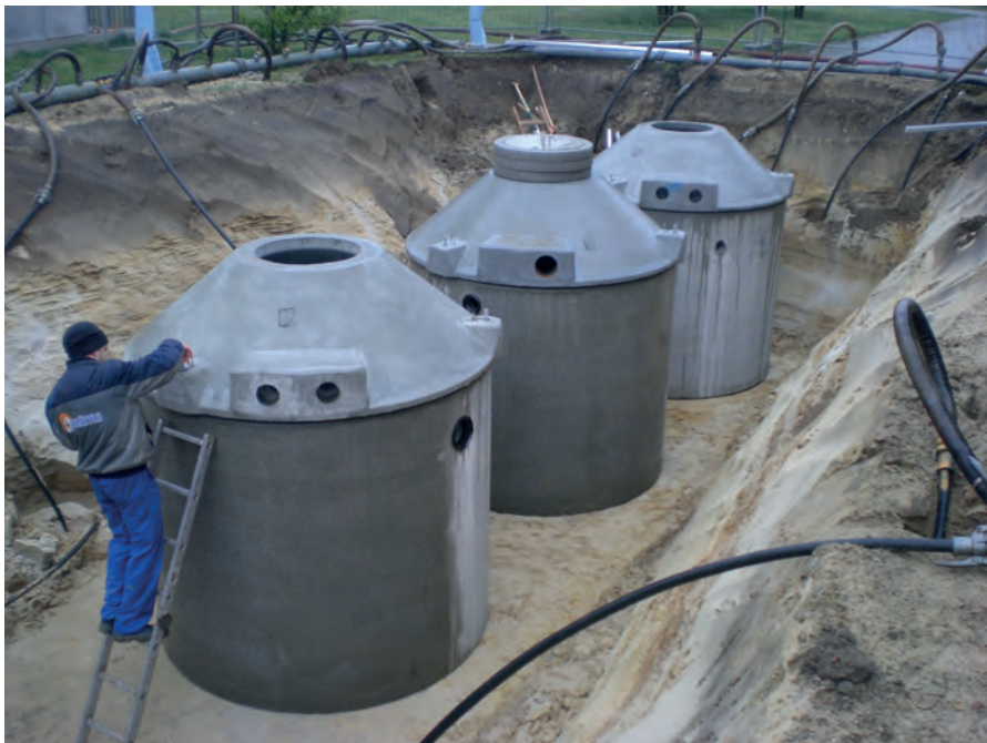
Versetzen der Betonbehälter im Erdreich. Zulauf von Duschen und Badewannen in den 1. Tank, Membranbiologie im 2. Tank, Klarwasser zur Entnahme mit zwei Unterwasser-Zubringerpumpen im 3. Tank. Foto: Mall
