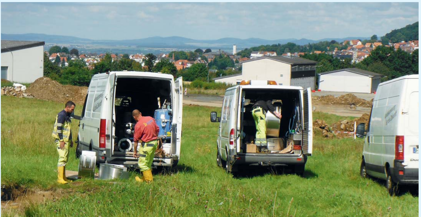
Bild 1 Homberg/Efze, Gewerbegebiet Süd, ehemalige Ostpreußenkaserne: Erstmals werden 32 Stück der zweiteiligen Linerendmanschetten Quick-Lock BIG in begehbaren Kanälen DN 800 und DN 900 eingesetzt.
