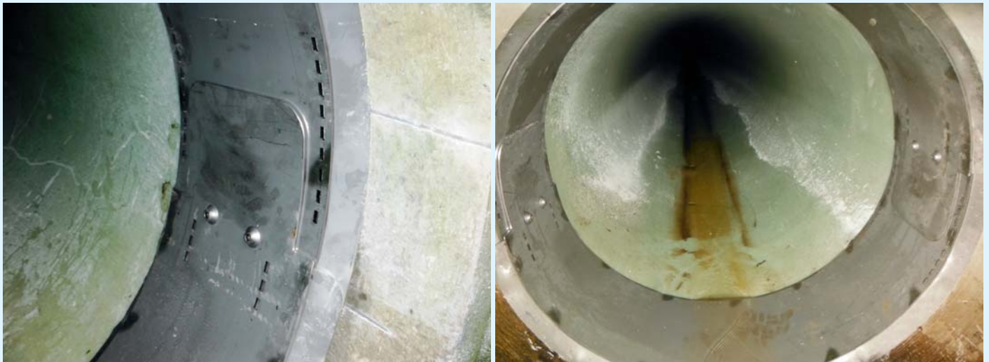
Bilder 6 und 7 Fertig installierte Linerendmanschette, System Quick-Lock BIG, als Schachtanschluss
