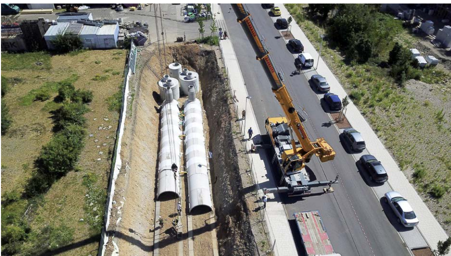
(1) Sickeranlage Süd mit zwei Rigolensträngen: Dahinter jeweils ein Filter- und der Verteilerschacht. Das Versetzen auf die vorbereiteten Streifenfundamente erfolgte per Autokran. Die Tunnelsohle liegt hier bei 3,55 m unter Gelände.
