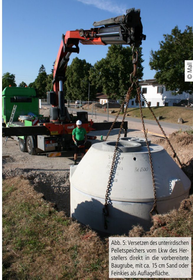
Abb. 6: Der unterirdische Pelletspeicher mit Befüll- und Einstiegsöffnung. Je nach gewählter Abdeckung ist der Behälter für Pkw oder Lkw befahrbar.
