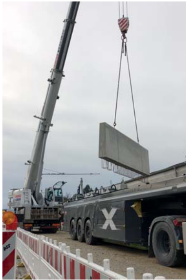
Bild 5: Lieferung der Betonteile per LKW auf Innen- lader-Paletten. © König
