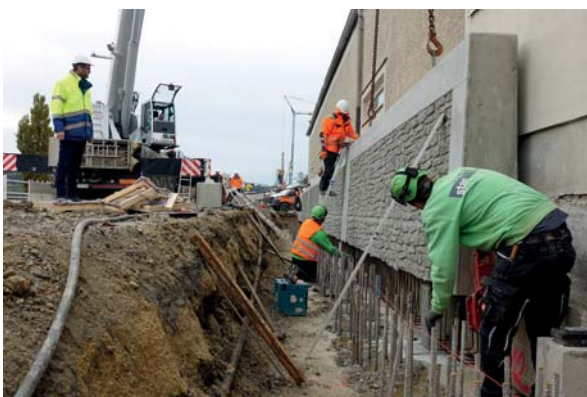
Bild 6: Die vorgefertigten Mauerelemente wurden beim Anhängen an den Autokran zentimetergenau so justiert und in die Horizontale gebracht, dass sie beim Absetzen exakt und schnell auf dem vorberei- teten Fundament fixiert werden konnten. © König
